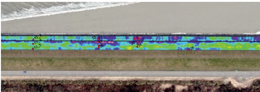
Inspectie asfaltkwaliteit Lauwersmeerdijk
